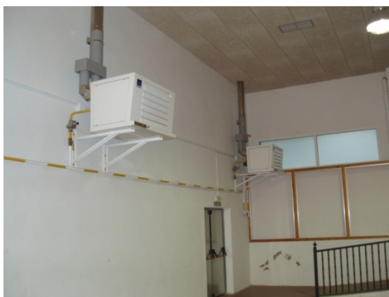
Ilustración 12: Foto radiadores aerotermos.
