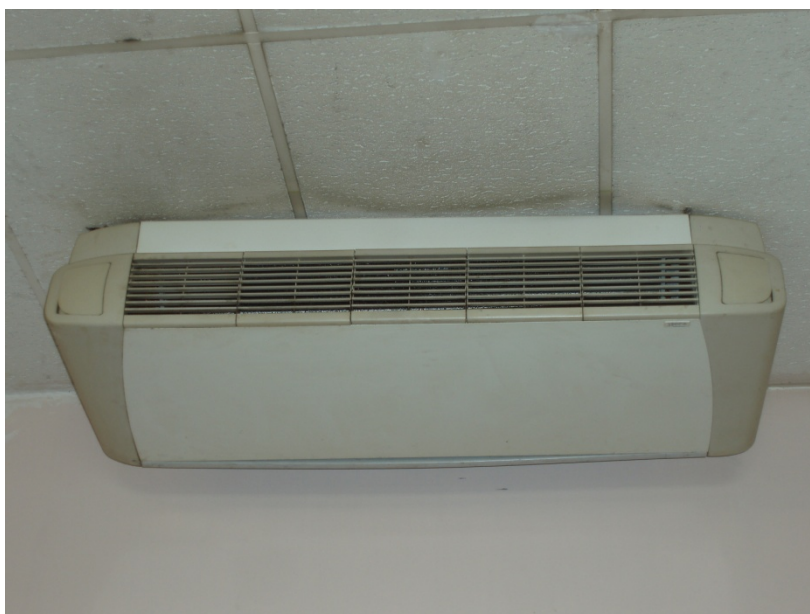
Ilustración 23: Foto Fancoil.
