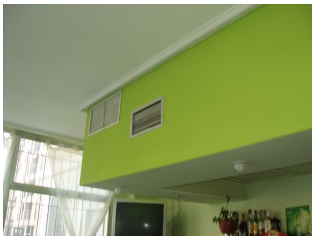
Ilustración 15: Foto rejillas de impulsión y retorno.
